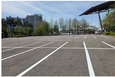
P4 주차장 시설 개선
