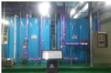
물 재이용시설 보수
